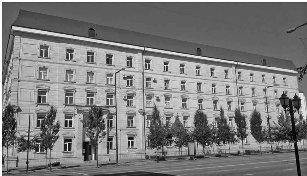
Строительный корпус ГГНТУ (2017 г.)
